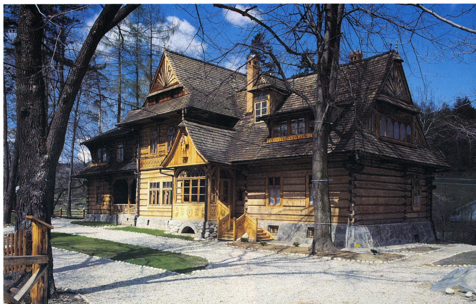
61. Willa „Koliba” – widok od pd-wsch., 1892–93, proj. Stanislaw Witkiewicz (skrzydło zach. dobudowane w 1901 r., prawdopodobnie wg proj. Tadeusza Praussa)
